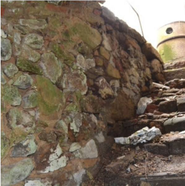
Treppe zum mittelalterlichen Keller Fotos: Probst
