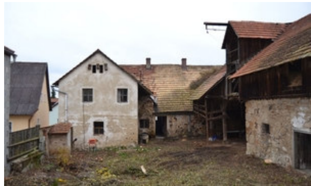
Das denkmalgeschützte Schießl-Anwesen steht seit Ende der 90er Jahre leer. Foto: Pöschko
