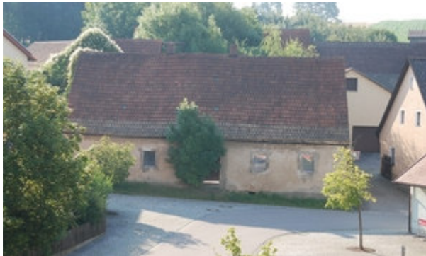
Das Schießl-Anwesen befindet sich im Ortszentrum von Neukirchen-Balbini. Foto: Probst
