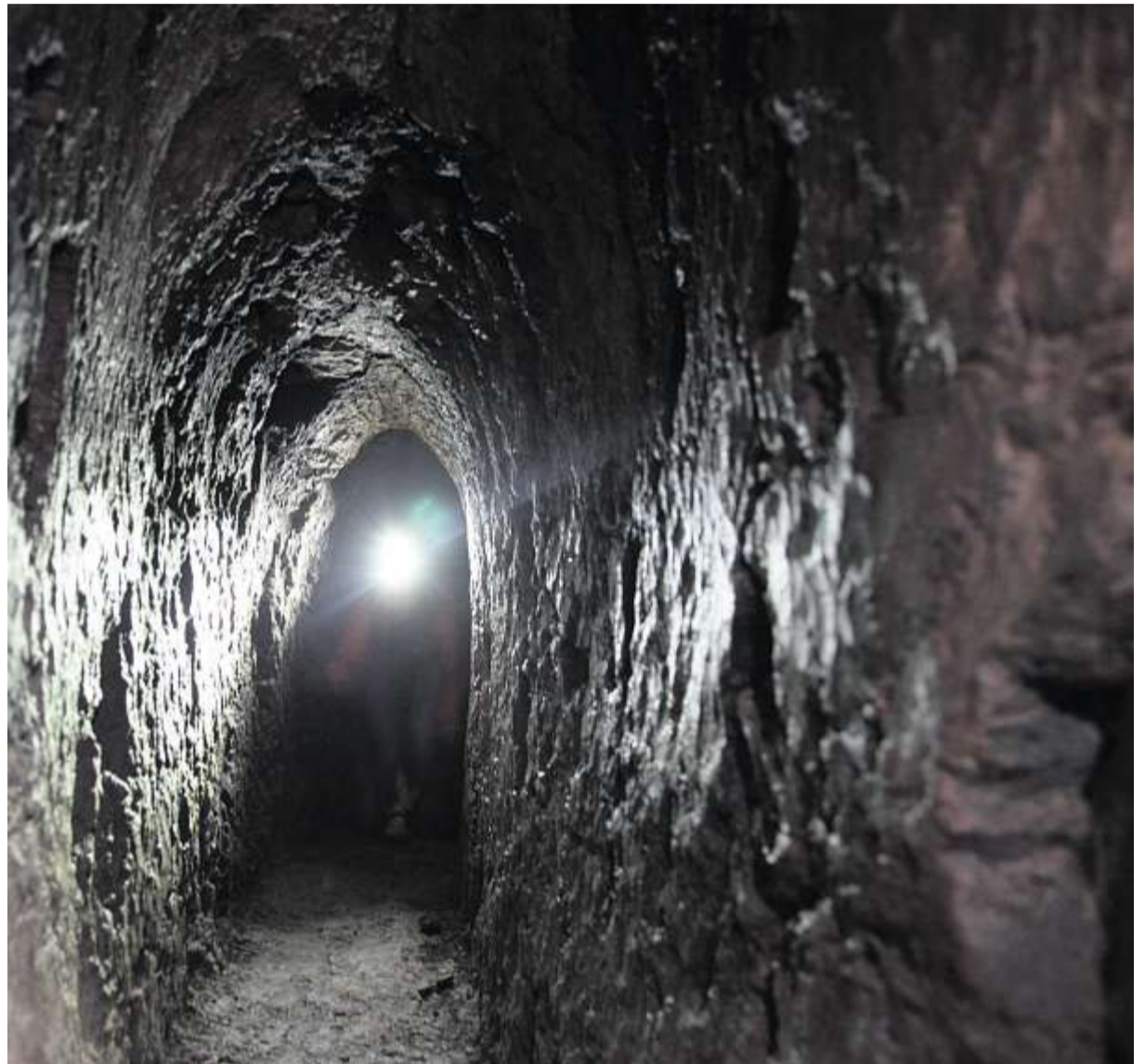
Ein Gang mit Spitzbogen im Erdstall von Mitterschneidhart. Je nach Beschaffenheit des Untergrundes haben Erdställe Spitz- oder Rundbogen und folgen damit alten Bergbauregeln. Fotos: Daniel Pfeifer
